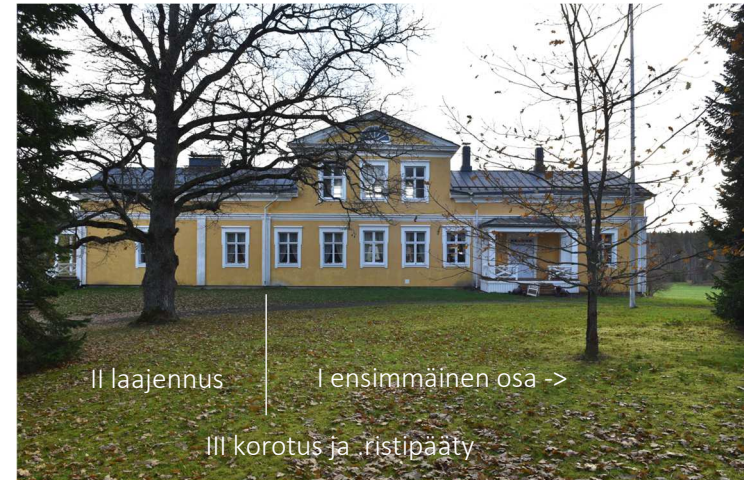
Kuva: Loukion päärakennuksen pohjoisjulkisivu.
