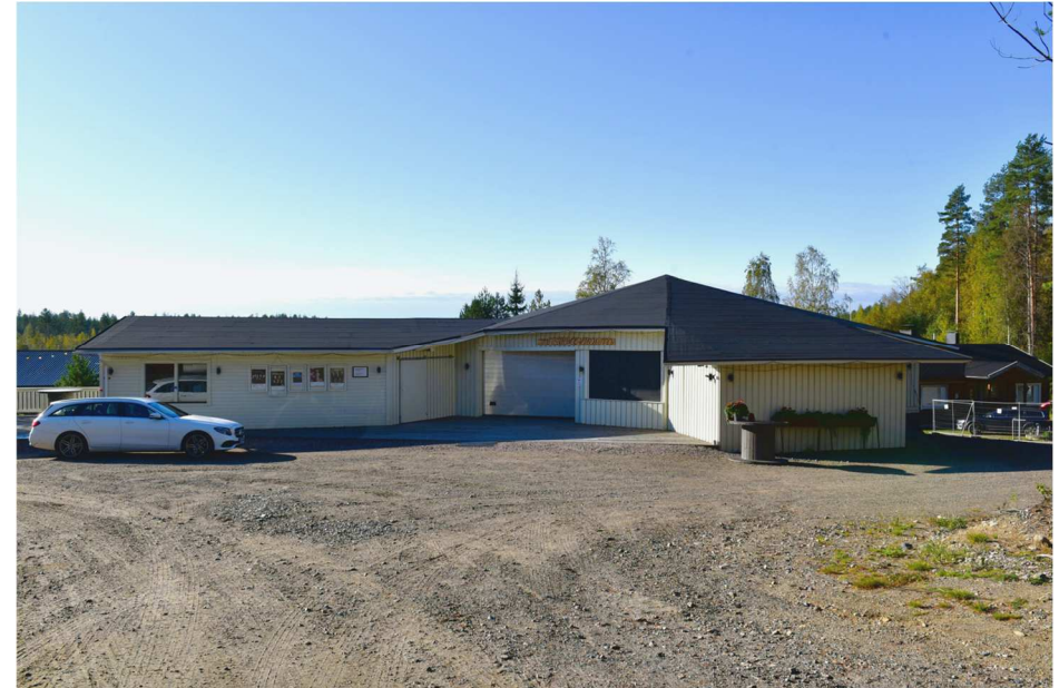
Kuva: 1950-60-lukujen lautarakenteiset lavat ovat tyyliltään yksinkertaisia ja pelkistettyjä. Teräsovi on tehty rakennuksen ollessa veneveistämänä.
