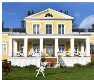
Kuva: Pilarien uusi jyrkevä ilme on tehty levyverhouksella. Kaiteessa pystysäle on vaihtunut ristikkoon.
